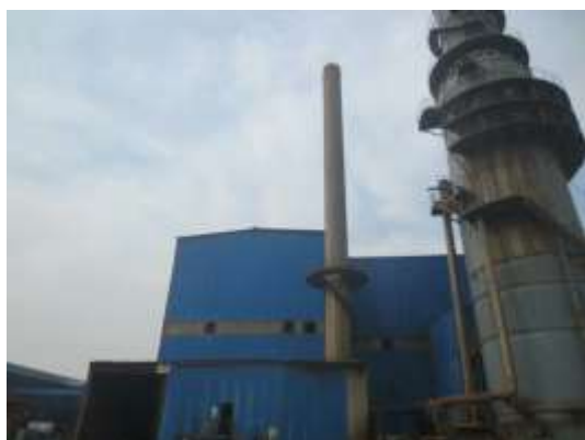
2#35t/h 燃气锅炉排气筒
